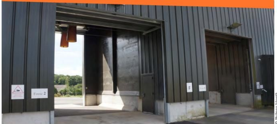
→ Les deux fosses de déchargement offrent une capacité cumulée de 500 t/h. De quoi assurer un circuit rapide de collecte aux agriculteurs adhérents lors de la moisson.
