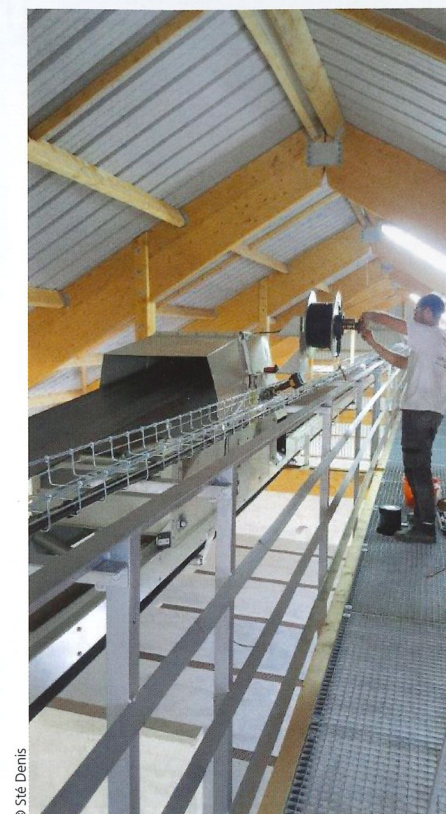
→ Le convoyeur à bande et son chariot déverseur motorisé.
