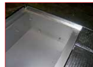
Intérieur d'un caniveau
